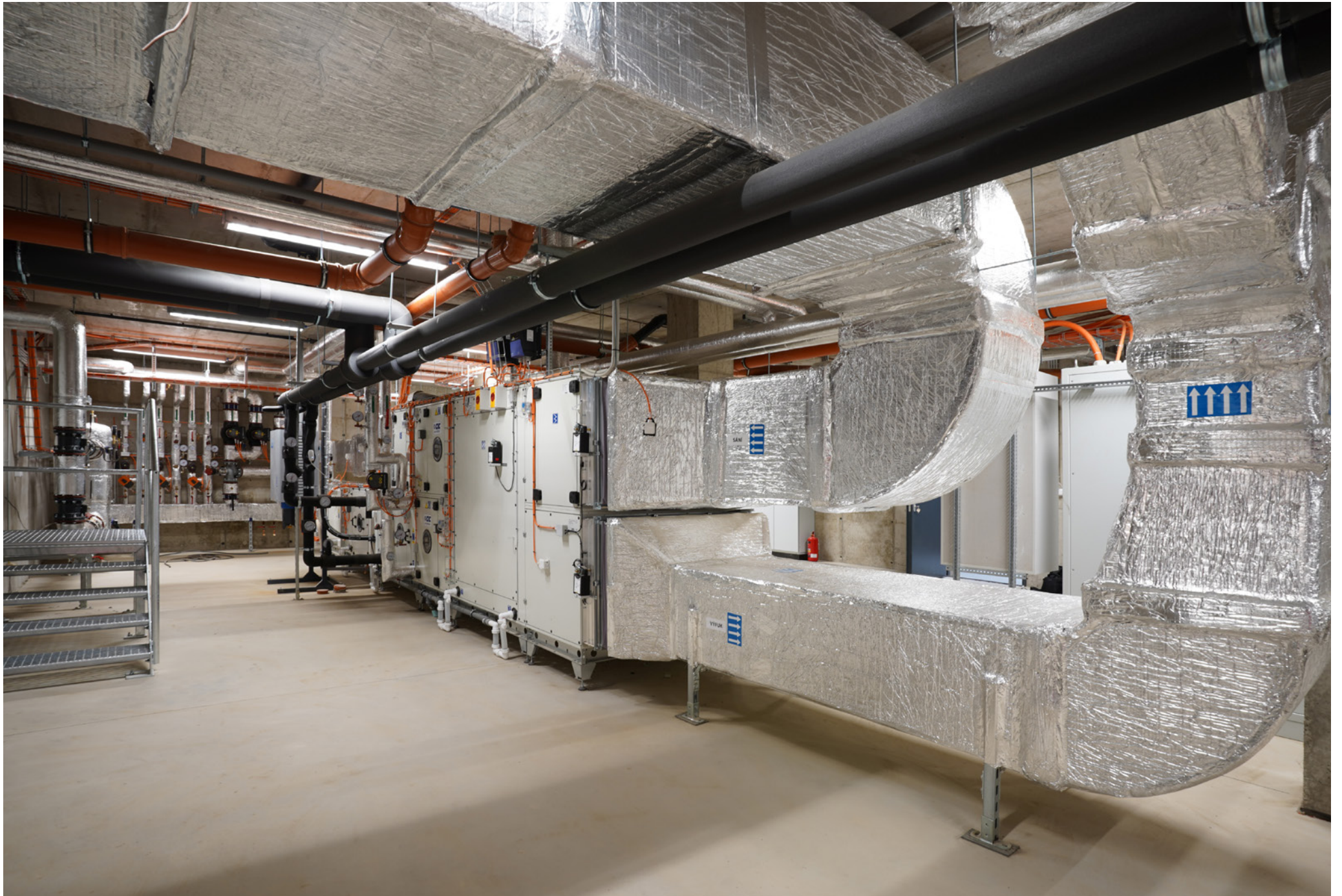
Extension of the modular surgical pavilion | Karvinská hornická nemocnice a.s | Czech Republic | 2024
